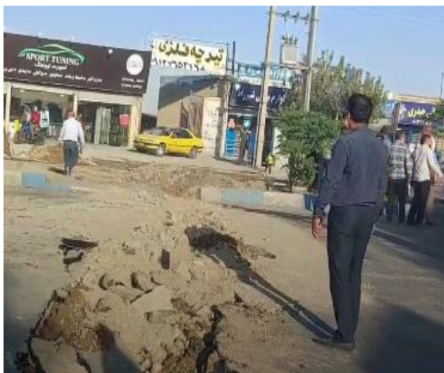
شکل (۱۰) برداشت میدانی ۰۱ مهر ۱۴۰۳، فرونشست جاده در محور آدران شهریار
