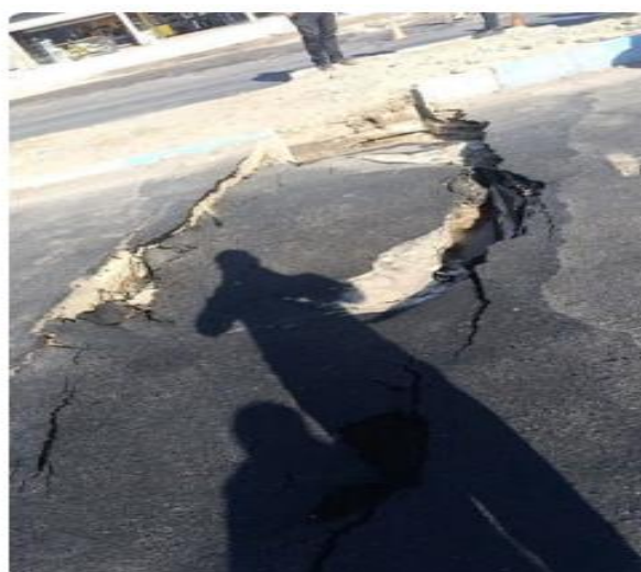
شکل (۱۰) برداشت میدانی ۰۱ مهر ۱۴۰۳، فرونشست جاده در محور آدران شهریار
