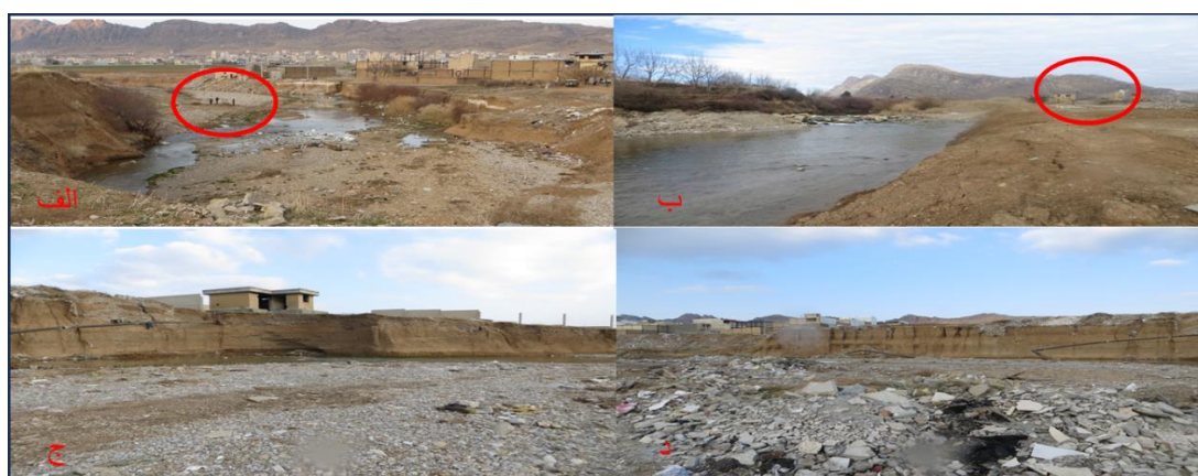
شکل (۳): (الف) برداشت غیر مجاز شن و ماسه از بستر رودخانه، (ب) معدن برداشت شن و ماسه، (ج) فرسایش کناره ای رودخانه، (د) اشغال دشت سیلابی در بخش اول رودخانه خرم رود
