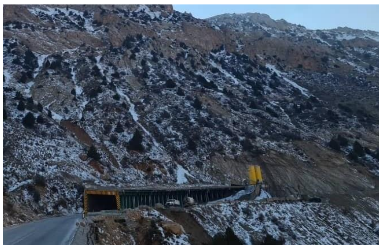
شکل (۲): نمونه‌ای از بهمن‌گیر در مسیر ارتباطی جاده هراز در حوالی آب اسک (منبع: نگارندگان)
