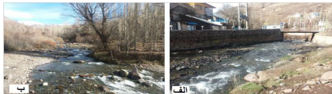
شکل (۲) الف) دیوار چینی و ساخت پل ب) بستر گراولی و دست‌نخورده در بازه ۱ Fig (2) a) A rip rap and bridge construction b) undisturbed and gravel bed in the first reach
