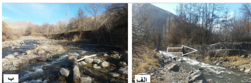
شکل (۳) الف) سنگچینی دیواره و گابیون‌بندی ب) واریزه‌های چوبی، رسوبات گراولی و قطعه سنگی
